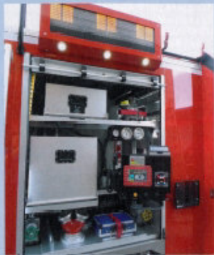
Die Bedieneinheit für Pumpe und Schaummittel-Druckmischanlage kann herausgeschwenkt werden. Ein blauer Koffer enthält Material zur Atemschutzüberwachung.
